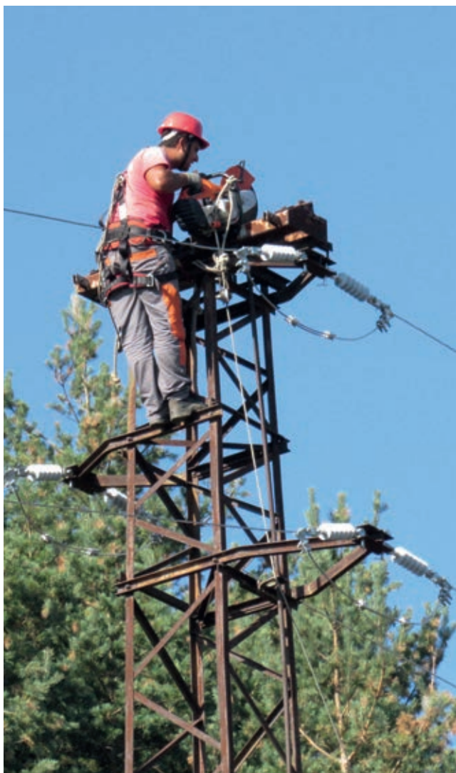
КЕЦ Кърджали: ремонт на желязо-решетъчен стълб по въздушна линия средно напрежение „Ардино“.
