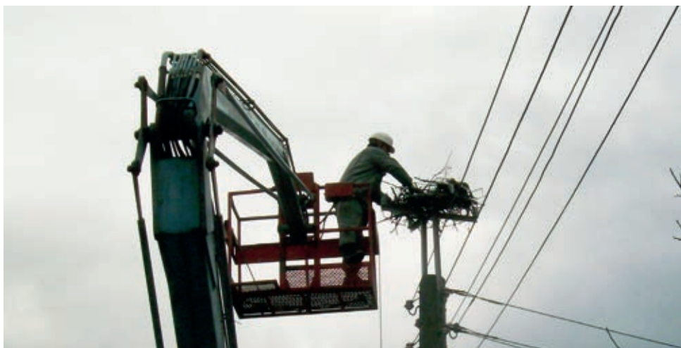
Монтиране на обезопасителна платформа за щъркели от новия подобрен вид в района на Кърджали.
