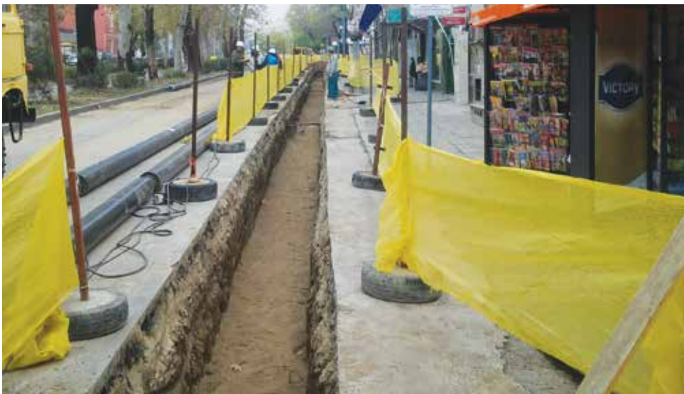
Една от знаковите инвестиции на EVN България Топлофикация през лято 2013 включваше изграждане на топлопровод по централния бул. „Руски“ в гр. Пловдив.
