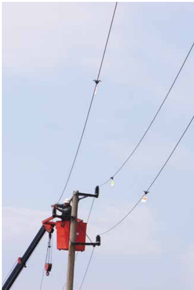
През 2013 г. за първи път в България EVN България и БДЗП монтираха дивертори по въздушни електропроводи от електроразпределителната мрежа в района на Атанасовското езеро край гр. Бургас.
