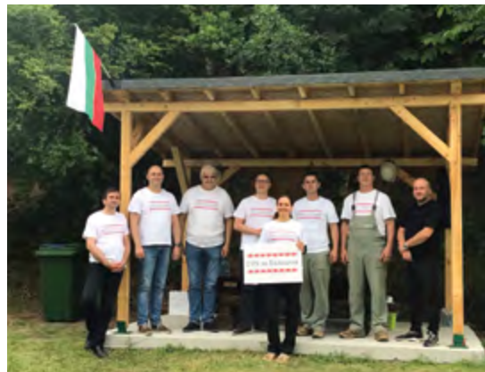
Ремонтирахме въжен мост в с. Турия, община Павел Баня и подобрихме състоянието на кът за отдих в непосредствена близост до него.
