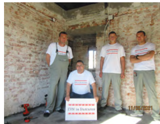
Проектирахме и монтирахме изцяло нова електрическа инсталация на опожарена къща в гр. Момчилград.
