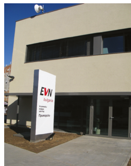
Сградата на КЕЦ Приморско
